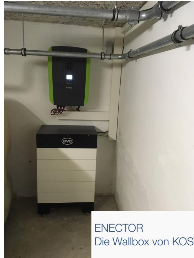
KOSTAL Hybrid-Wechselrichter plus modulare BYD-Batterie
